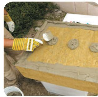
**Нанесение клея:** нанесите клей Энерджи Стар на плитку периметрально-точечным методом. Площадь клеевого контакта должна составлять не менее 40%.
