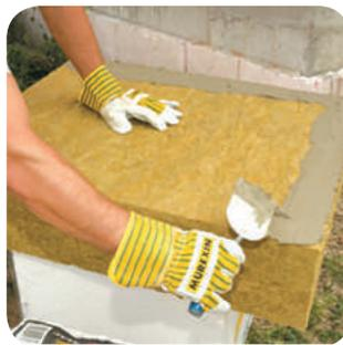
**Нанесение клея:** загрузите плитку по периметру тонким слоем клея Энерджи Стар.
