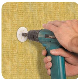
**Дюбелирование:** для крепления плит к пористым или деревянным основаниям используйте винтовые дюбели.
