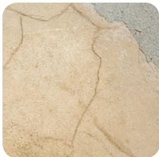
**Старые здания:** проверьте несущую способность основания, обработайте поверхность грунтовкой LF 10. Основание должно быть чистым, сухим и прочным.
