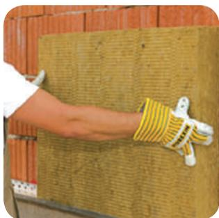
**Монтаж плит:** установите плитку в монтажное положение и плотно прижмите к основанию. Время выдержки не менее 1 сут.
